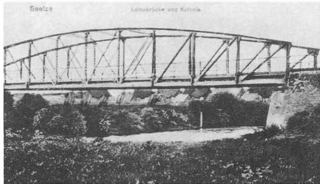
Abb. 4: Die alte Leinebrücke zwischen Seelze und Garbsen wurde 1938 durch eine neue ersetzt
