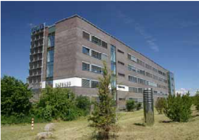
Südost-Ansicht des Rathauses
