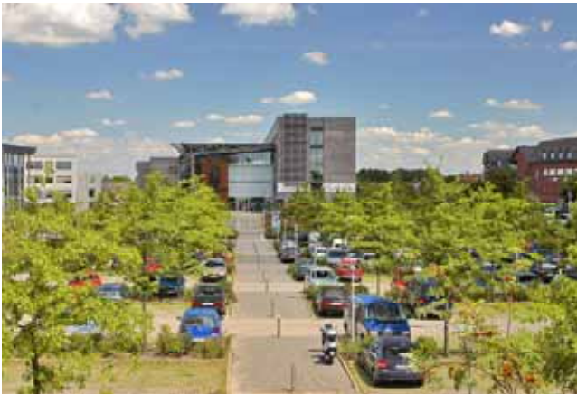
Blick von der Europaallee auf den Südeingang des Rathauses, im Mittelpunkt das Rathaus, östlich die Shopping Plaza
