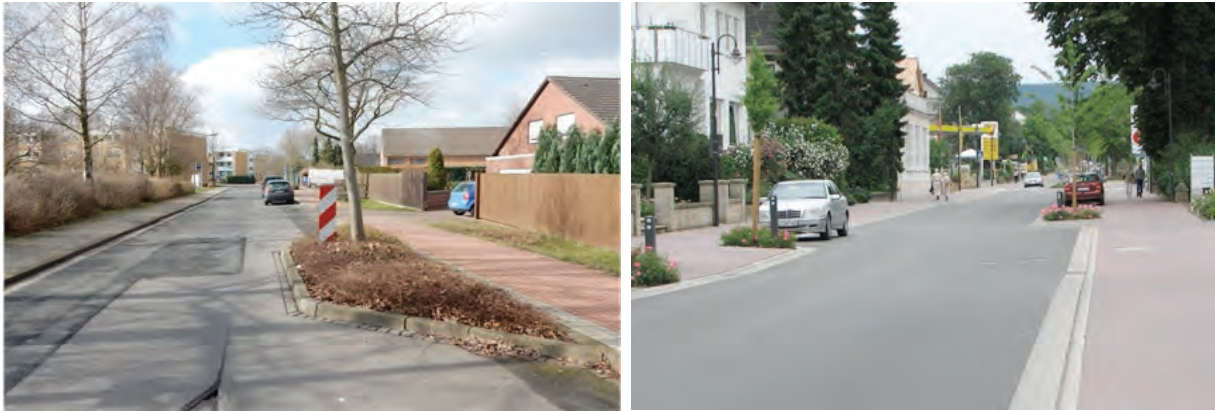
Gestaltungsbeispiele für das punktuelle Einfassen von Längsparkständen durch Baumscheiben (links: Neuer Landweg) (Fotos: SHP)
