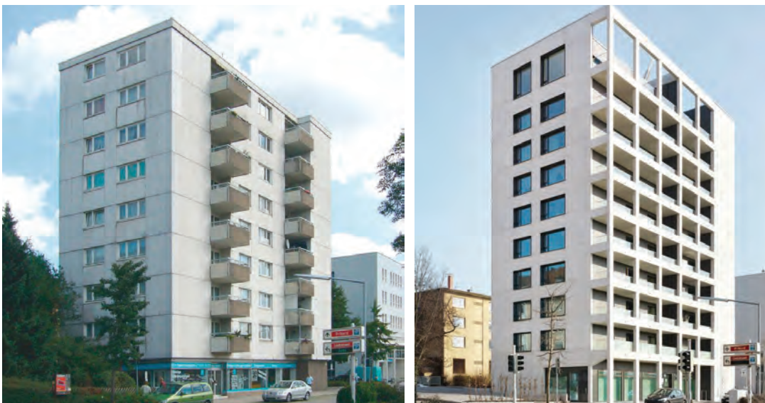
Abb.: Eisenbahner-Hochhaus in Pforzheim vor und nach der Sanierung
