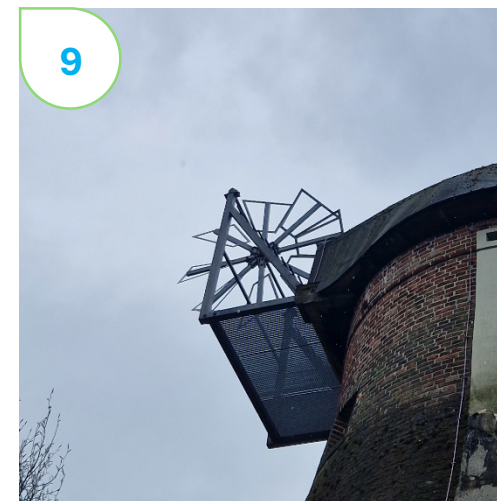
9 Wo der letzte erhaltene Turm von einst elf Bauwerken steht.
