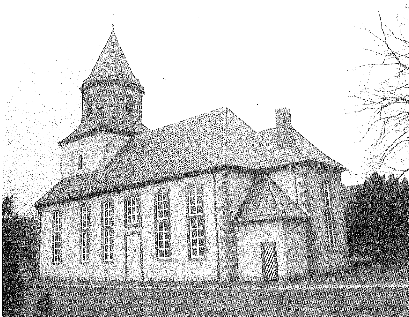
Abb. 9: Kirche in Osterwold · von Südosten, 1994
