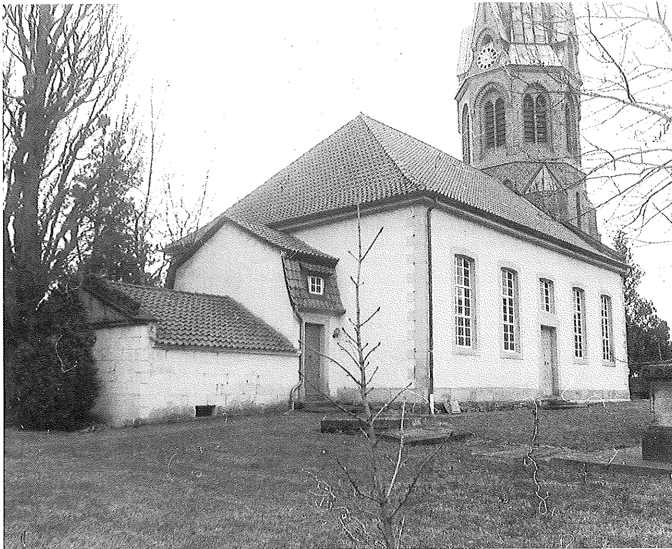
Abb. 6: Kirche in Horst · von Nordosten, 1994
